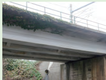
写真 1 海岸沿いの橋梁の桁
