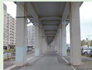
写真 2 海岸に近い高架橋の橋脚
